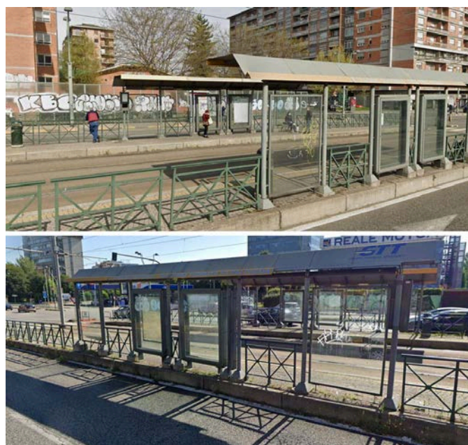
(Fermata in necessità di cura della linea 4, Oxilia, nei pressi del quartiere Rebaudengo; presenza di erbe spontanee, graffiti e assenza della mappa di rete, 2020, © Google)
