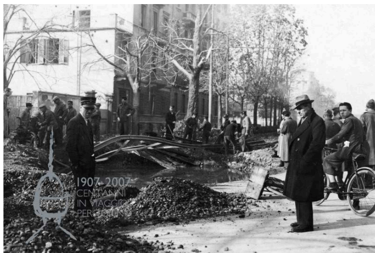
(Binari divelti in corso Francia dopo un bombardamento aereo, 1943, © Archivio GTT)
