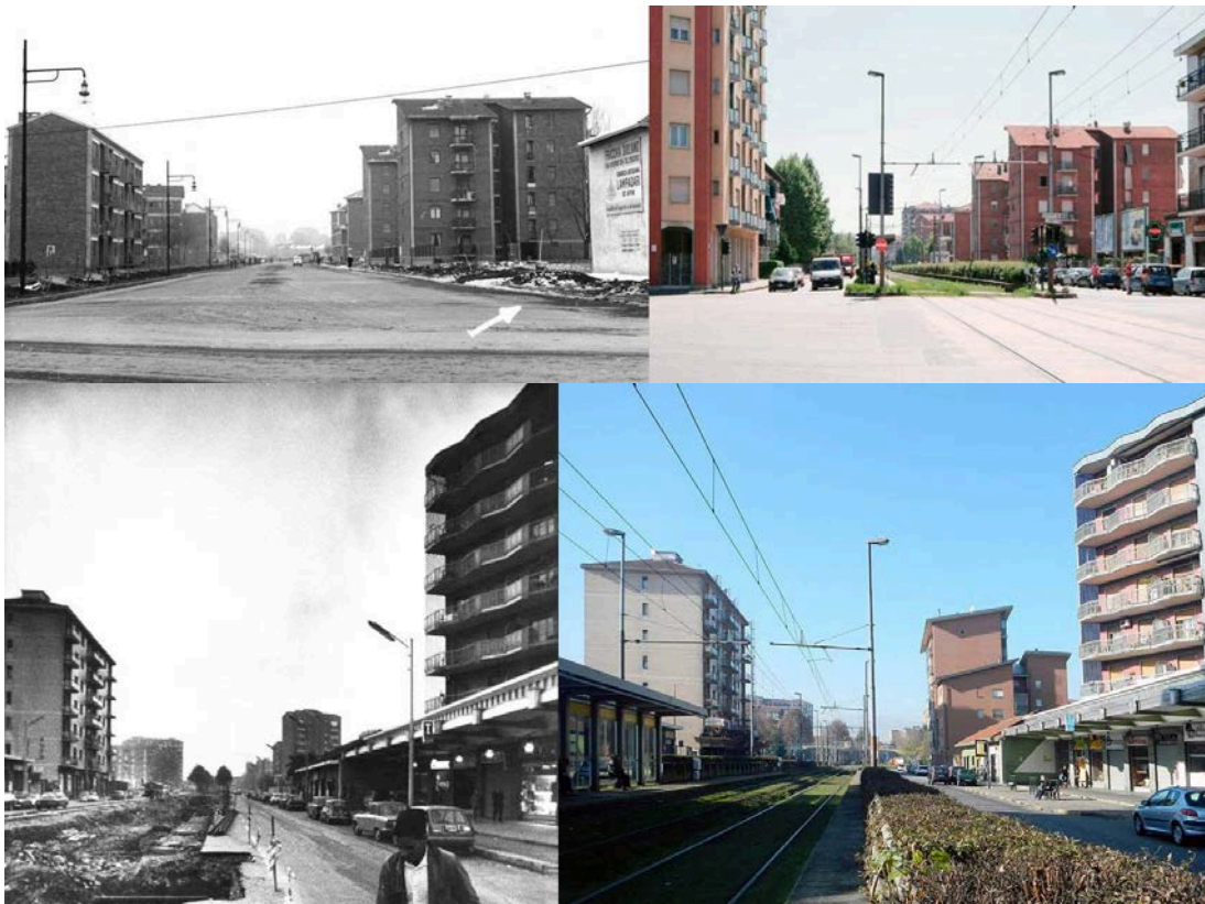
(Prima e dopo, costruzione della trincea tranviaria lungo Corso Toscana, 1950 e 1980 circa rispettivamente,
