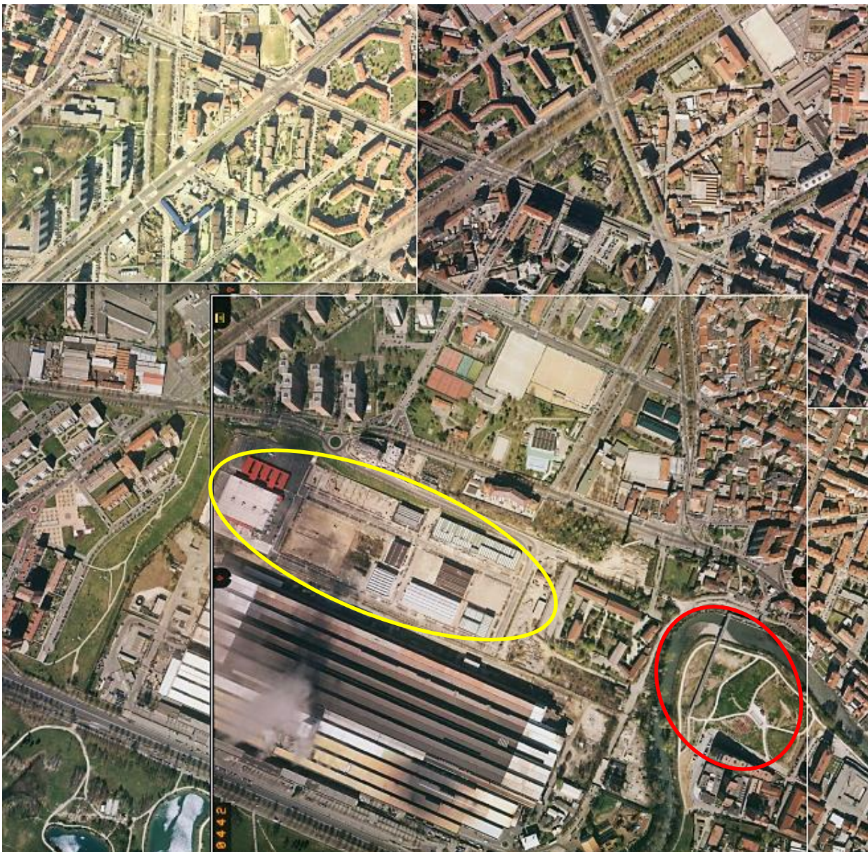
Fig. 109: Ortofoto aerea sulla zona Lucento, Pellerina del Comune di Torino.
