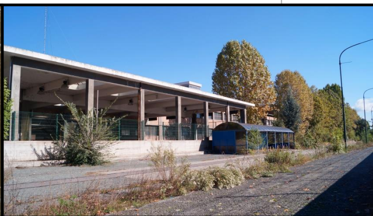
Fig. 111: L'ingresso allo stabilimento oggi, in stato di abbandono e degrado.
