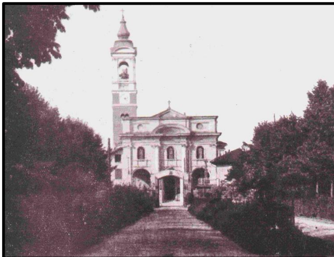
Fig. 52: Chiesa parrocchiale vista dall'interno dell'istituto Bonafous nel 1930
