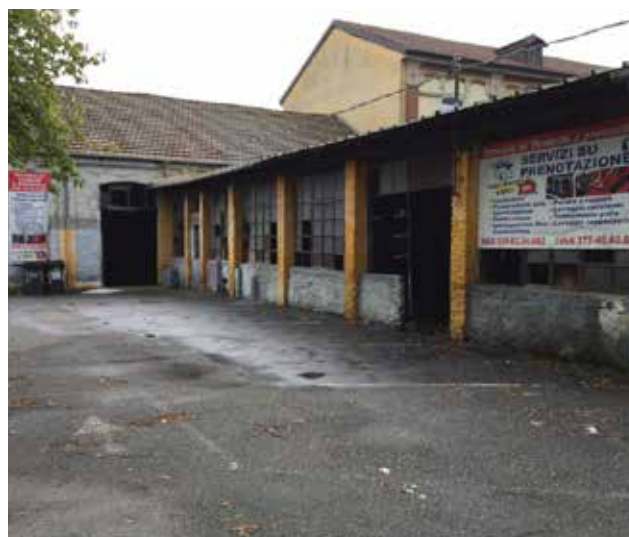
Cortile interno e manica civico n.175 - Fonte: www.comune.torino.it
