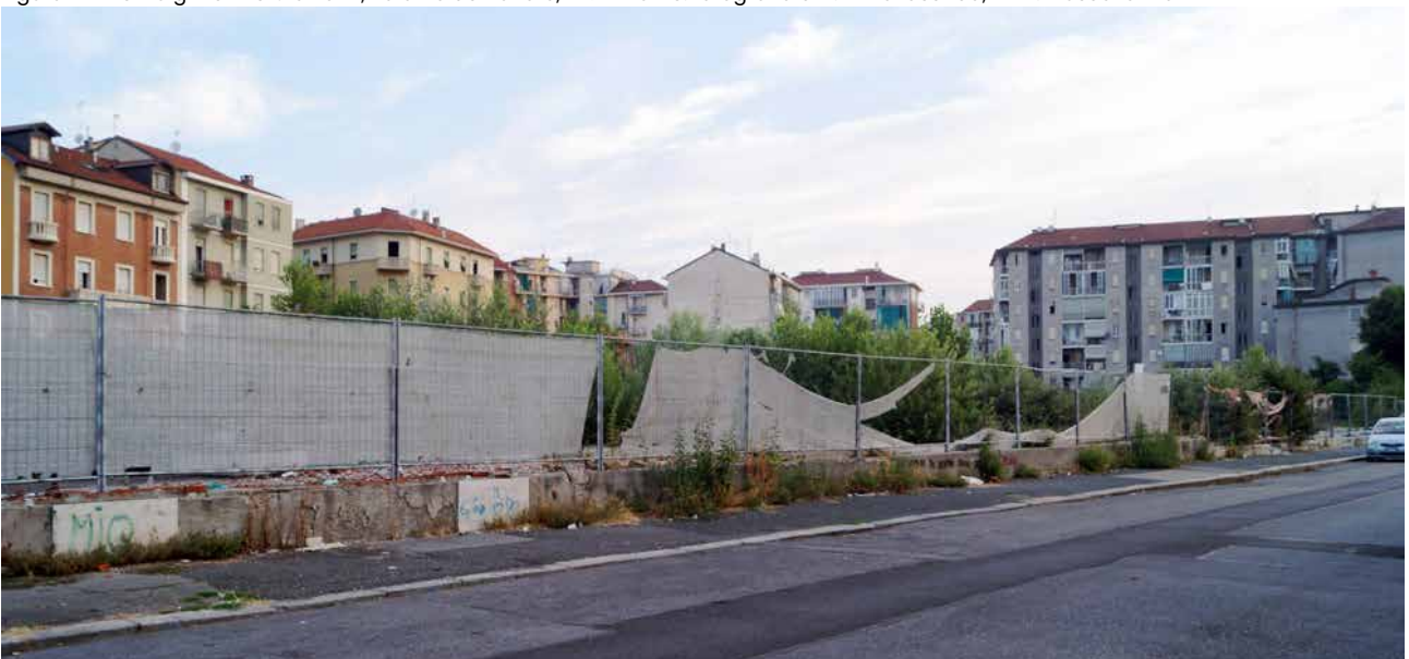
Figura 3 - Vuoto urbano via Bellardi 55, Torino; già azienda meccanica Ghibaudo - Fonte: Immagini del Cambiamento, 2018
