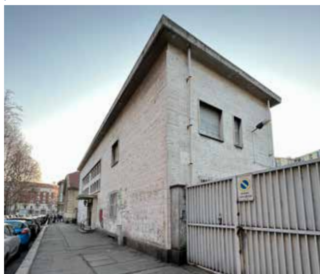
Fronte su via Conte di Roccavione - Fonte: propria
