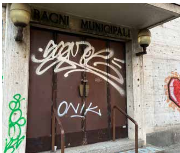
Ingresso bagni municipali - Fonte: propria
