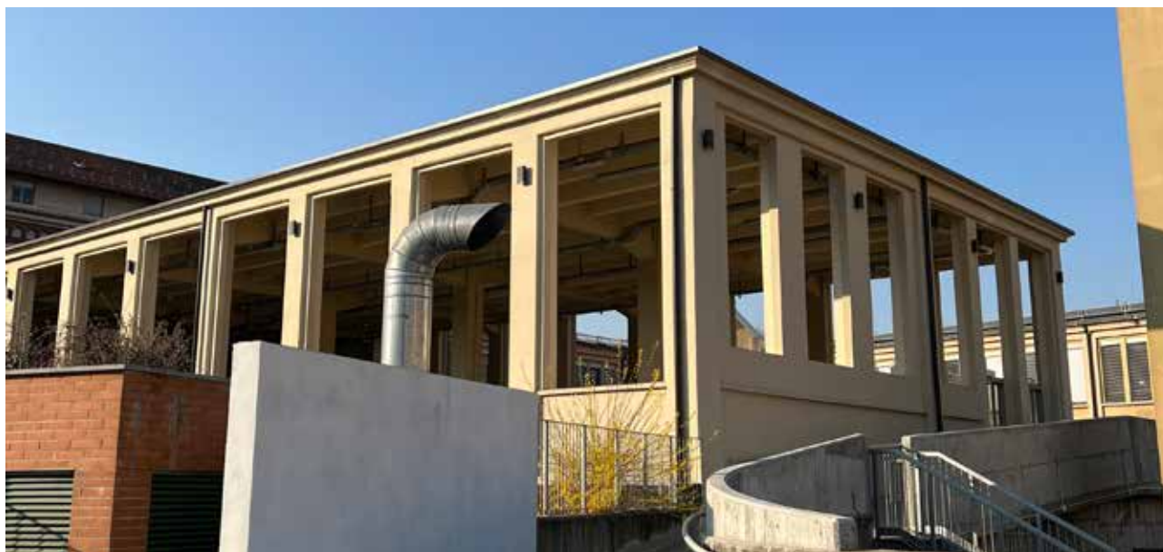
Figura 3 - A1, via Cumiana 15. Ex stabilimento Lancia. - Fonte: foto propria
