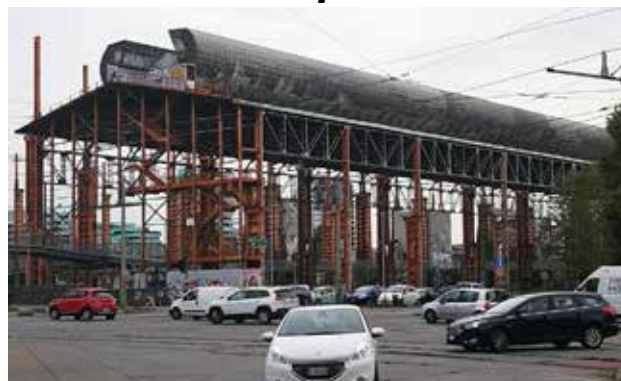
Figura 20 - Scheletro dell'ex fabbrica in corso Mortara nel 2021 Fonte: Immagini del Cambiamento
