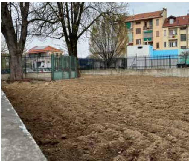
Interno via Cavagnolo 9, dopo - Fonte: propria
