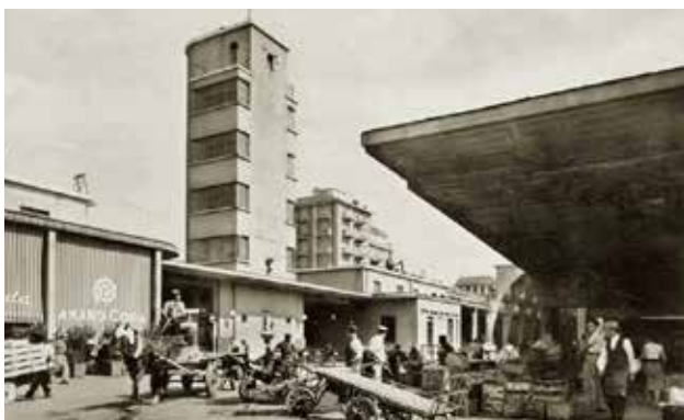
Figura 27 - Mercati Generali in piazza Galimberti 24 negli anni 50. Fonte: Archivio Giorgio Pelassa
