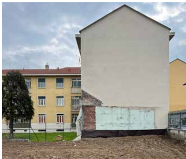
Interno via Cavagnolo 9, dopo - Fonte: propria
