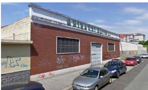
Figura 36 - Ex Ghibaudi azienda meccanica in via Bellardi nel 2011. Fonte: Google Street View
