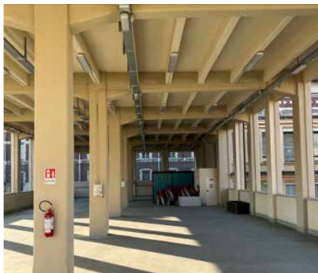
Interno piano rialzato dopo - Fonte: propria
