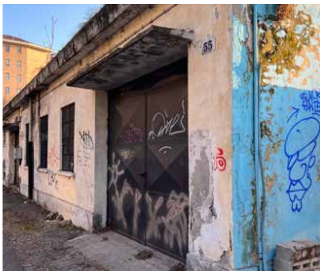
Ingresso al deposito - Fonte: propria
