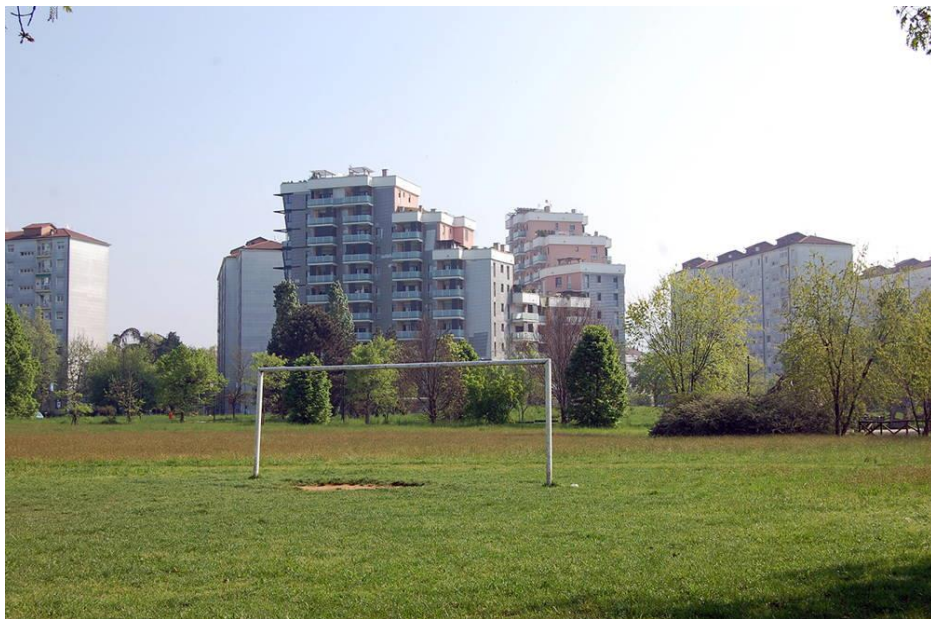
Figura 18 Nuovo edificio ricostruito dopo il 2003, via Fratelli Garrone 79 - Mirafiori Sud - 2017 - fonte: Elena Piaia - Immagini del cambiamento
